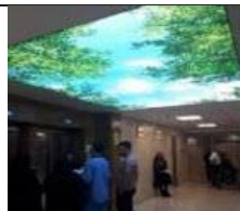
- آسمان مجازی در سقف کاذب
