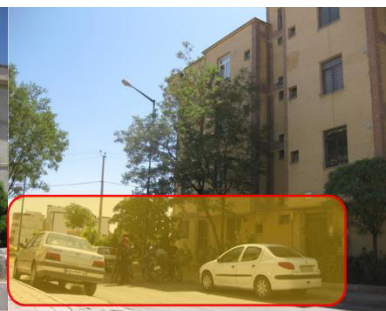
عدم تعریف شدگی ورودی‌ها در مجموعه اعتمادیه
