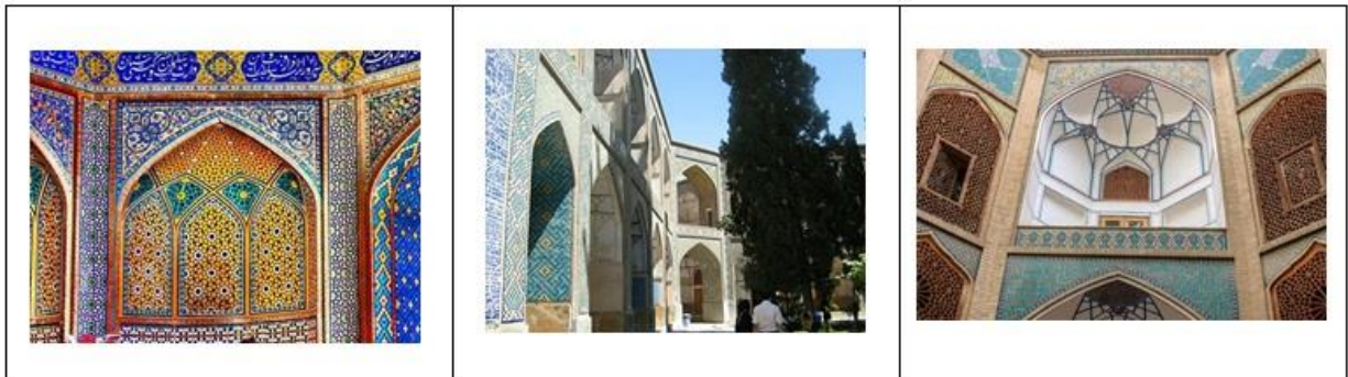
تصویر ۷- تصاویری از تزئینات کاشیکاری، گچکاری بدنه‌های حیاط
