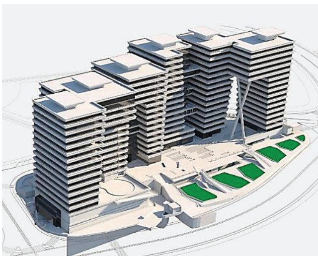
تصویر ۸- برج‌های مسکونی پزشکان آبشار
