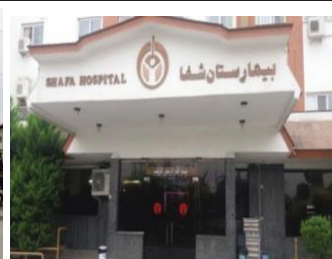
ورودی اصلی بنای بیمارستان
