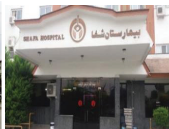
ورودی اصلی بنای بیمارستان
