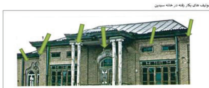
نمای جنوبی خانه سیدین - ساخت: مؤلف ۱- روزن های بالای پنجره ها جهت تهویه هوا و ورود نور به داخل فضاها ۲- پنجره های روبه حیاط - ۵ لنگه با کتیبه های شیشه ای در بالای آنها
