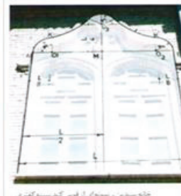
خانه سیدین - نمونه ای از قوس کند شیشه آجری
