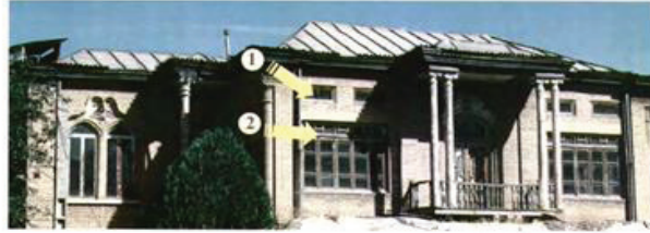
نمای جنوبی خانه سیدین - مأخذ: مؤلف ۱- روزن های بالای پنجره ها جهت تهویه هوا و ورود نور به داخل فضاها ۲- پنجره های روبه حیاط - ۳- لنگه یا کتیبه های شیشه ای در بالای آنها
