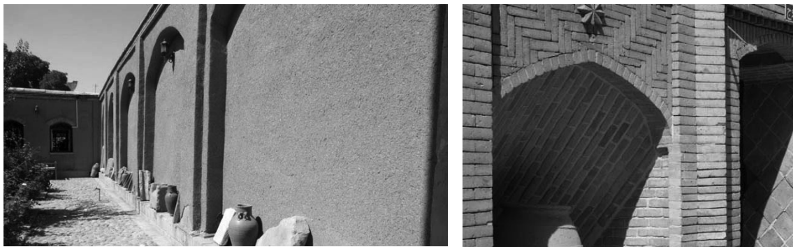
شکل ۵) مصالح خستی و آجری بکار رفته در مجموعه لطفعلیان که داری ظرفیت گرمایی بالا می باشد و متناسب با نیاز مجموعه می باشد (ماخذ: نگارنده)
